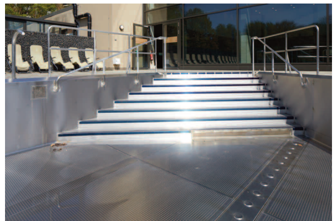
Abbildung 5: Beckenentleerung mit System
